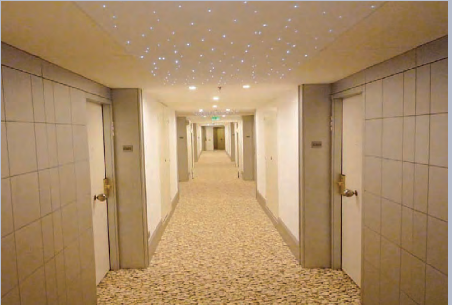
Soffitto con fibre ottiche
