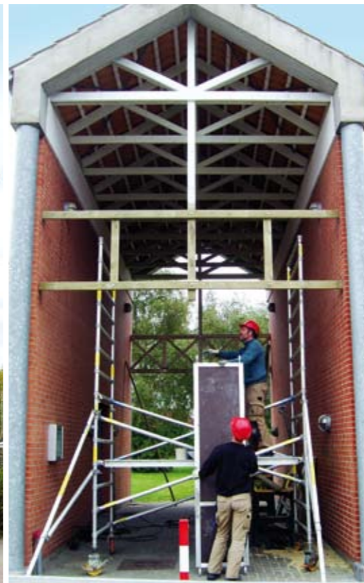
Portal renovering hos boligforening.
